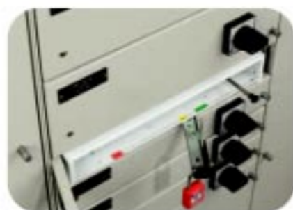
测试位置提高了安装 和调试过程中的安全性
