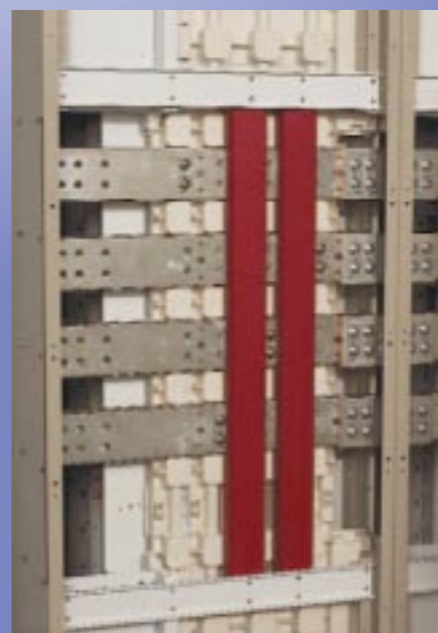
水平母排与垂直母排的连接 - 双栓连接使出现“热点” 的可能性降至最小
